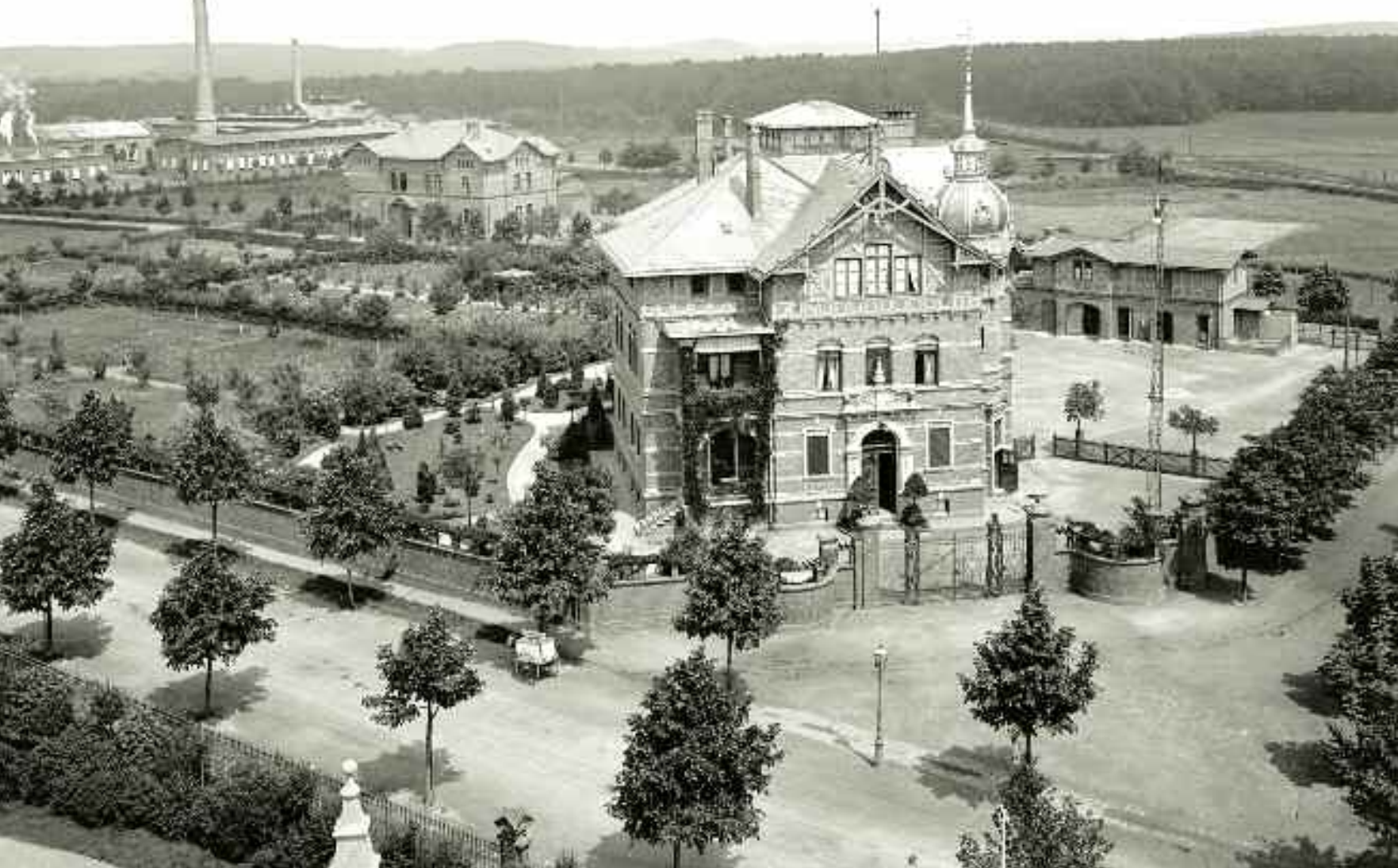
Die Direktorenvilla des Feuerwerkslaboratoriums an der Luisenstraße, 1910
