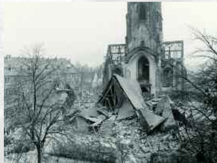
Die Annokirche nach der erfolgten Sprengung des Kirchenschiffs am 7. April 1970
