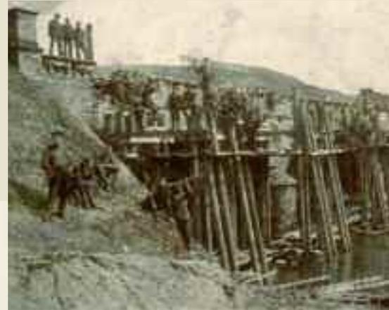
Die durch das Hochwasser eingestürzte Eisenbahnbrücke bei Herchen
